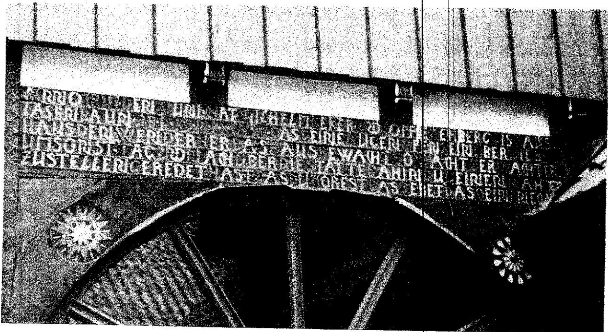
Torbogen des Hauses Rehberg, Papenhausen 12 (Foto: Ulrich Gronemeier, Lieme, 1995)
